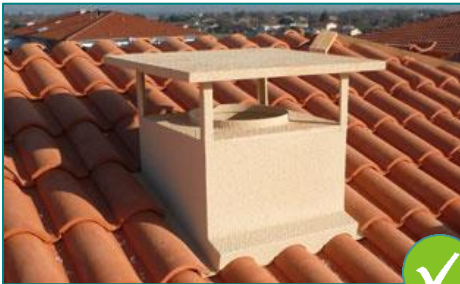
1 : Sortie de toiture correcte
