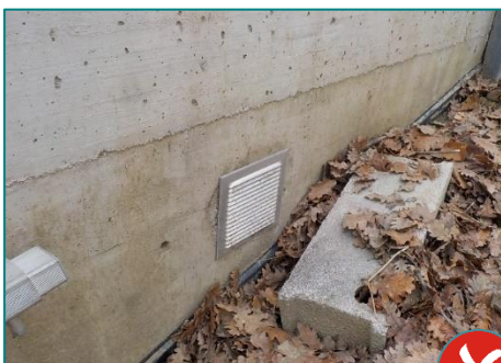
2 : Prise d'air à proximité du sol et donc des poussières
