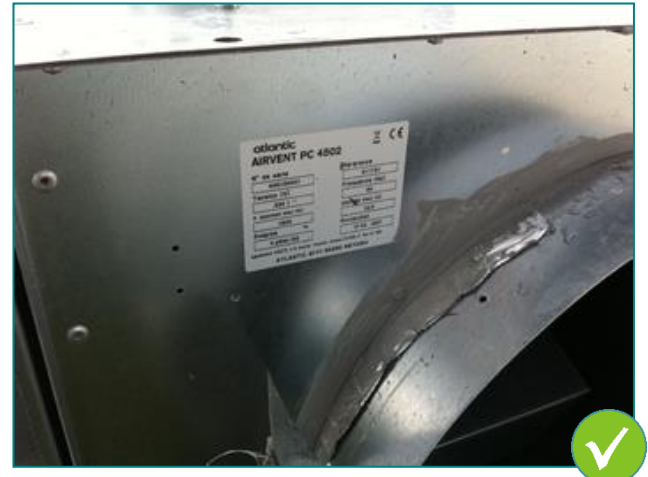
2 : Références lisibles sur une étiquette de caisson de ventilation d'un bâtiment de logements collectifs
