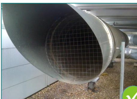
3 : Prise d'air protégée par une grille
