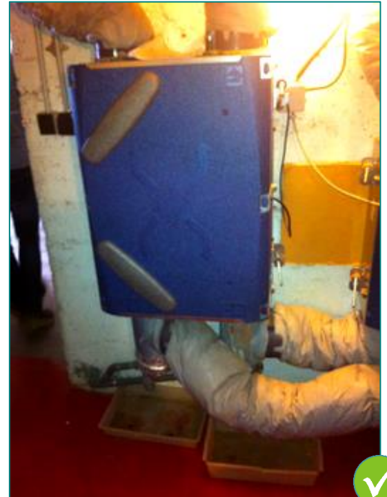
2 : Caisson de ventilation double flux isolé installé dans un volume non chauffé et non isolé
