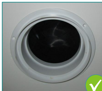
1 : Conduit raccordé avec une manchette de raccordement correctement installée
