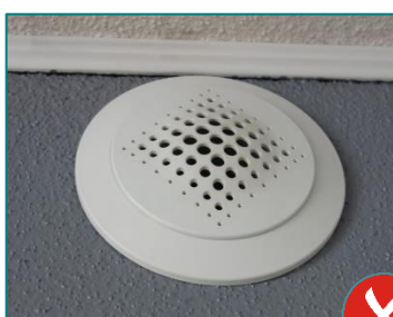
2 : Bouche collée à une paroi
