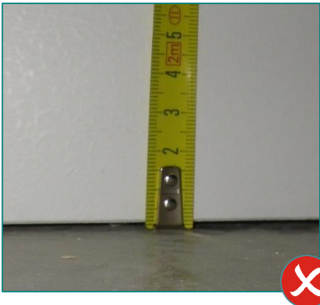
2 : Détalonnage insuffisant
