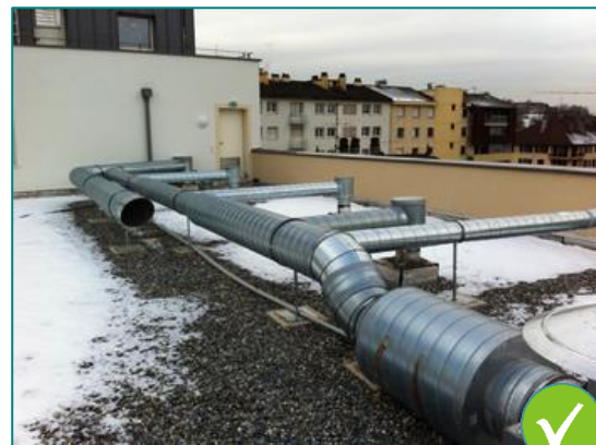
3 : Porte d'accès et cheminement en toiture terrasse
