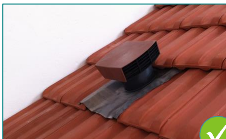
2 : Sortie de toiture correcte
