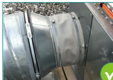
3 : Manchette correctement raccordée avec colliers de serrage
