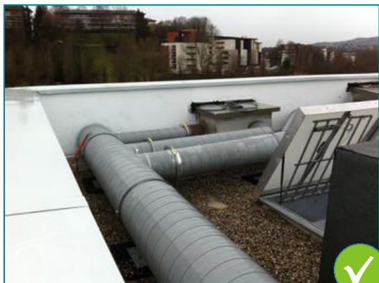
1 : Trappe d'accès à la toiture terrasse
