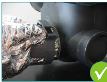
2 : Raccordements correctement réalisés avec colliers de serrage
